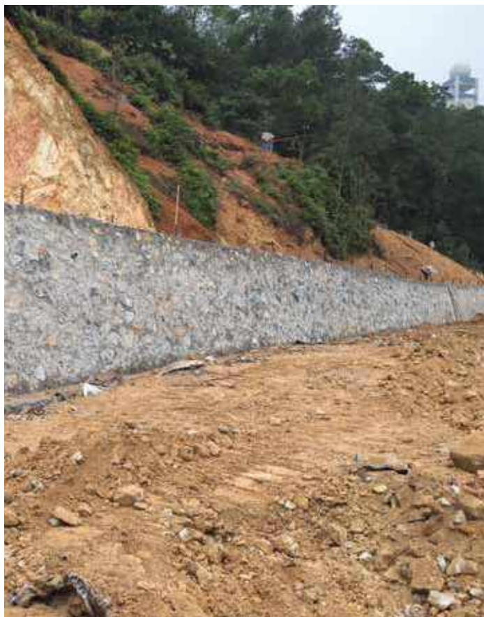
Thi công công trình Khắc phục hậu quả thiên tai năm 2018 tại Kho xăng dầu Cục Hậu cần/Quân khu 3
