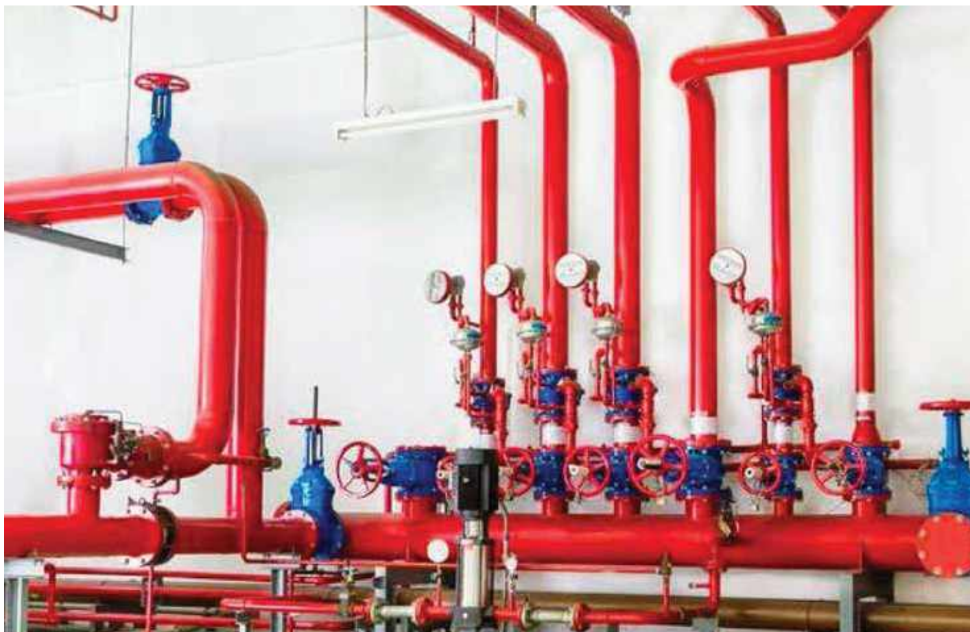
Thi công Hệ thống cứu hỏa nhà máy Z113
